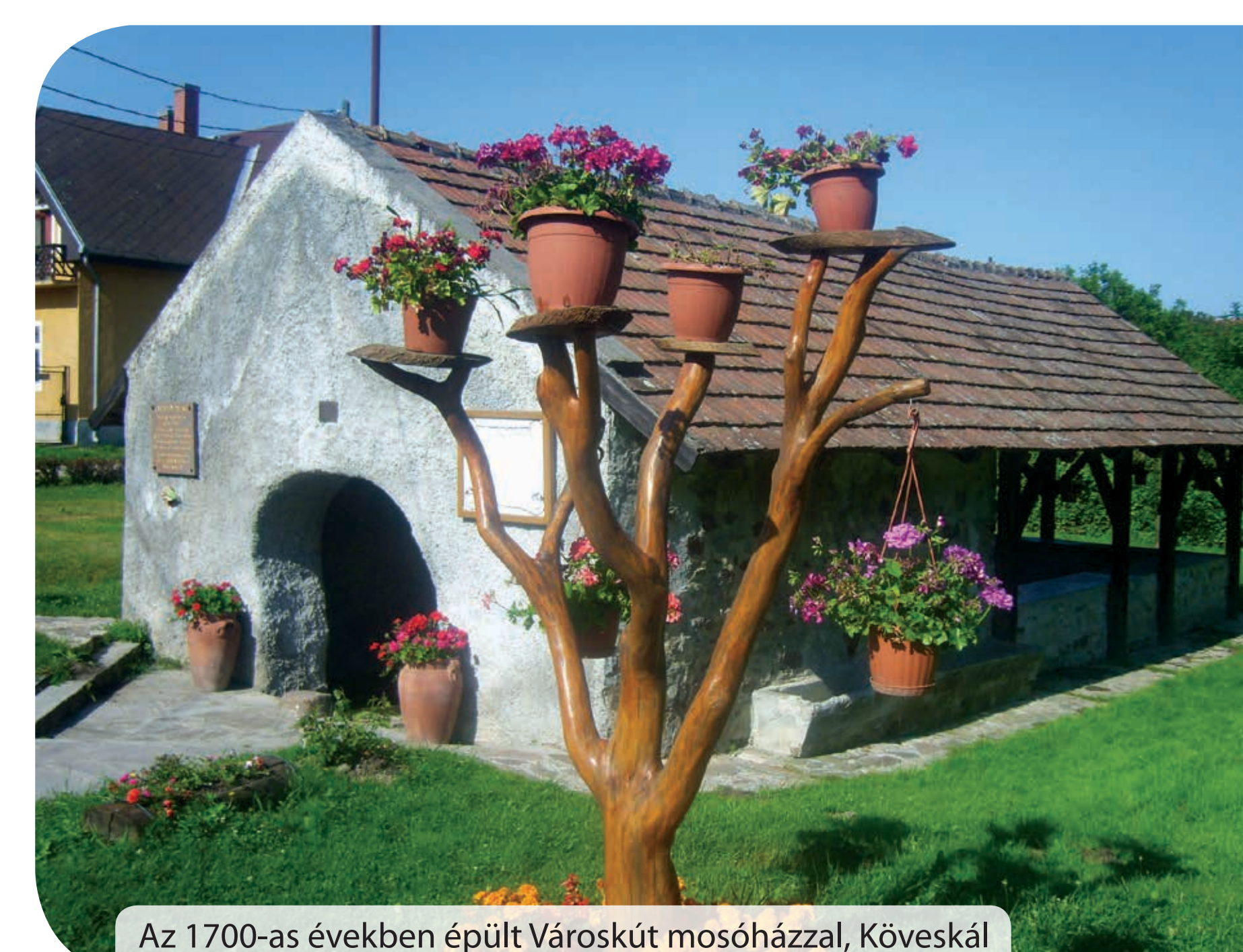
Az 1700-as években épült Városkút mosóházzal, Köveskál
